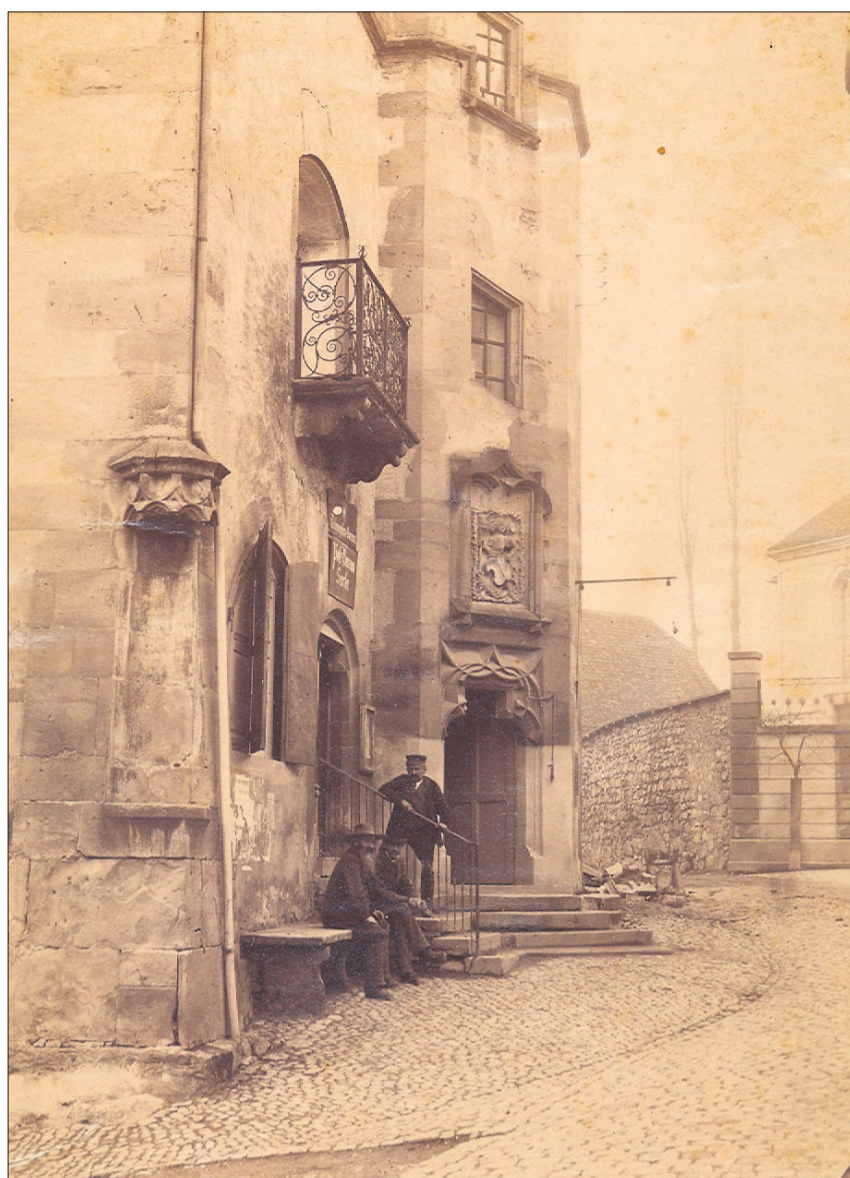
Der Pranger an der südöstlichen Ecke des spätgotischen Rathauses symbolisiert – wie schon auf dieser um 1900 entstandenen Fotografie – noch heute die Gerichtsbarkeit der Stadt Sursee. FOTO STADTARCHIV SURSEE, FOTOSAMMLUNG KORPORATION SURSEE
