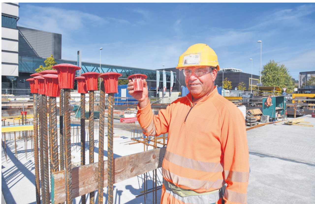
Zejnel Shala ist Magaziner – das «Mädchen für alles» – der Anliker AG auf der «Dreiklang»-Baustelle.
