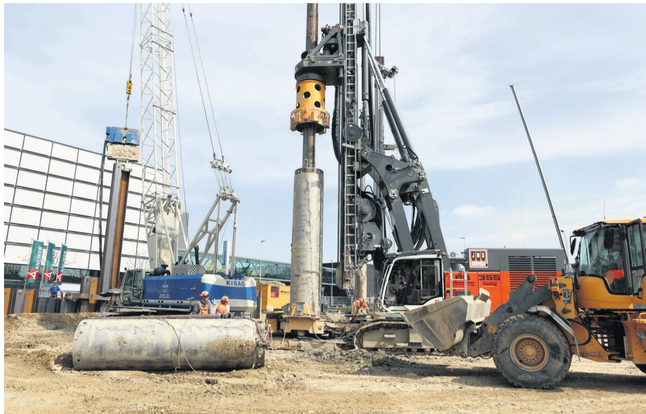
Während mithilfe des Grossbohrgeräts Löcher für die Pfähle gebohrt werden (Mitte), sorgen mit hochfrequenter Vibration ins Erdreich vorgetriebene Spundwände (links) für einen dichten Abschluss der Baugrube. FOTO ANA BIRCHLER-CRUZ
