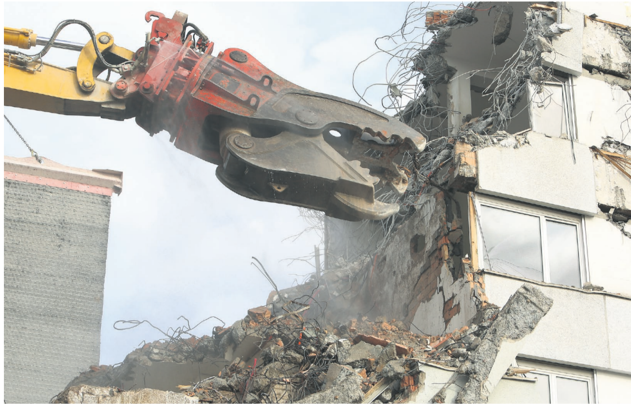
Mit hydraulischer Gewalt frisst sich die Zange des Abbruchbaggers durch die Stockwerke des Denner-Gebäudes.
