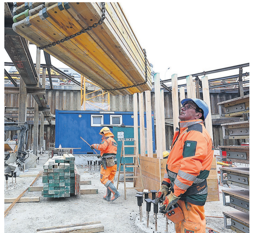
Luis Ruis – als Kranführer am blauen Helm zu erkennen – bediente derweil den kleineren Kran vom Boden aus mittels Fernsteuerung.
