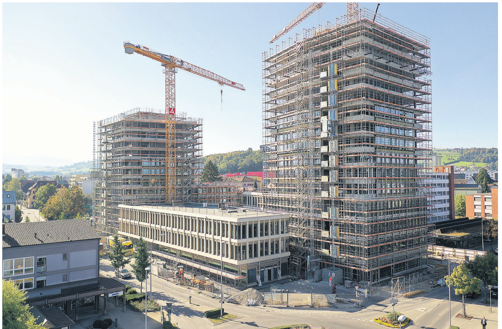
Seit wenigen Tagen ist der Rohbau der Überbauung «Dreiklang» in Sursee vollendet. Nun zeigt sie weitgehend das Gesicht, das man sich bisher nur aufgrund von Visualisierungen vorstellen konnte. FOTO CLAUDIO D'AMATO, BAULEITER ANLIKER AG GENERALUNTERNEHMUNG
