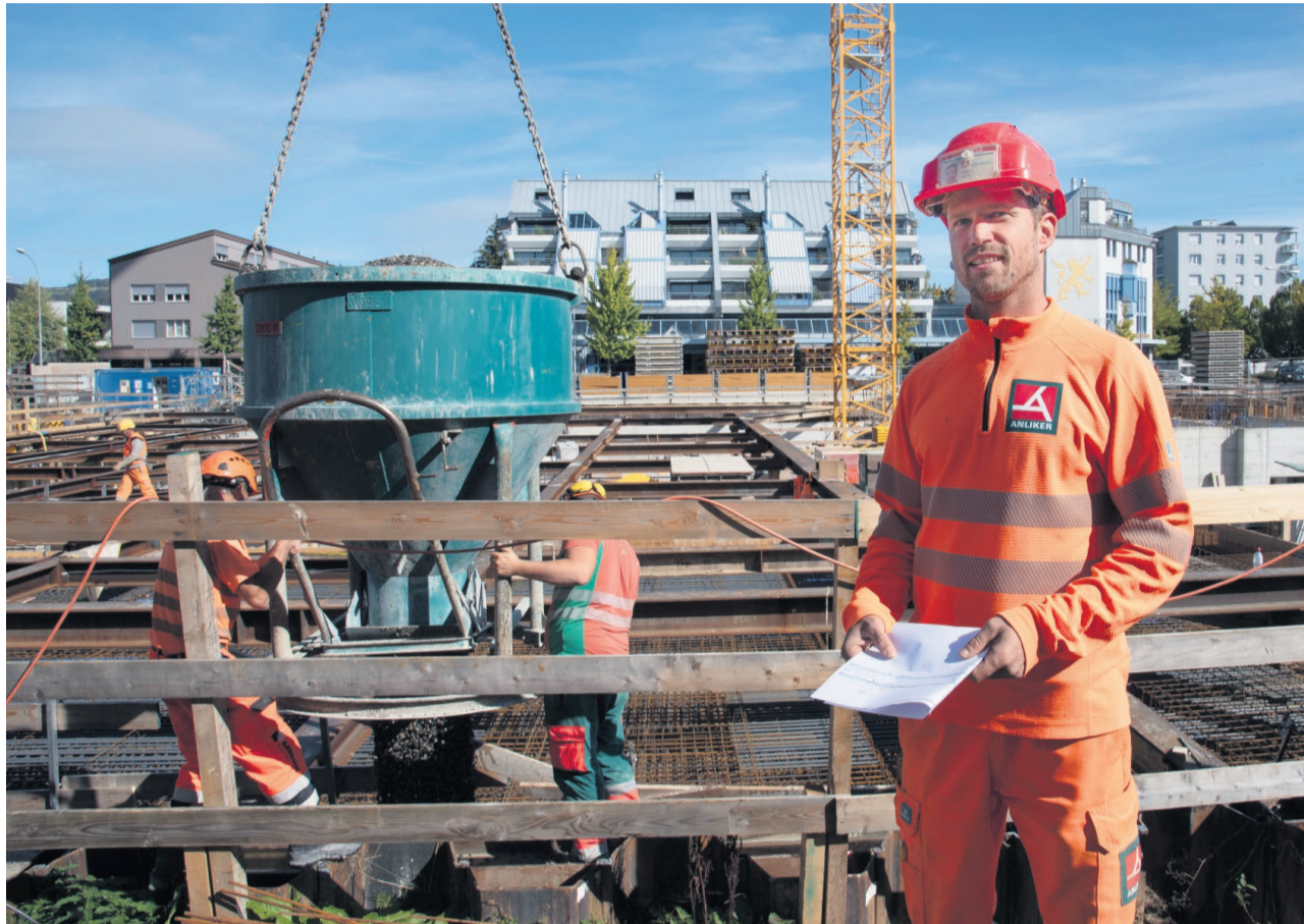
Adrian Götschi arbeitet als Polier der Anliker AG auf der «Dreiklang»-Baustelle.
