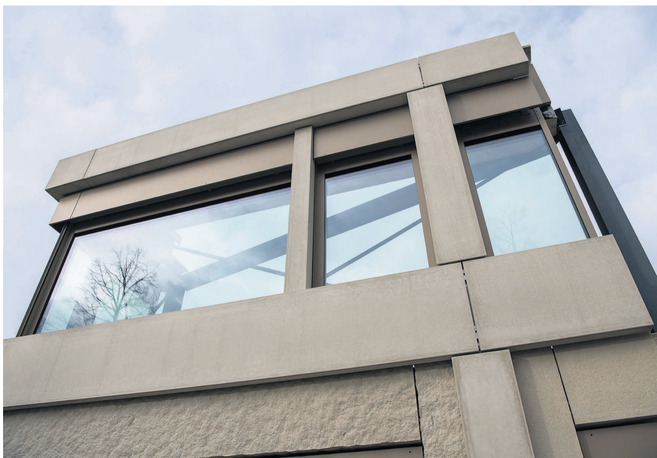
Blick auf ein Obergeschoss: Zwischen den isolierten Metallfenstern befinden sich eine kleinere Nebenlisenen (links) sowie die Hauptlisenen. Während Farben und Materialisierung den Plänen entsprechen, sind Dimensionen und Proportionen des Mock-ups nicht realitätsgetreu ausgeführt.
