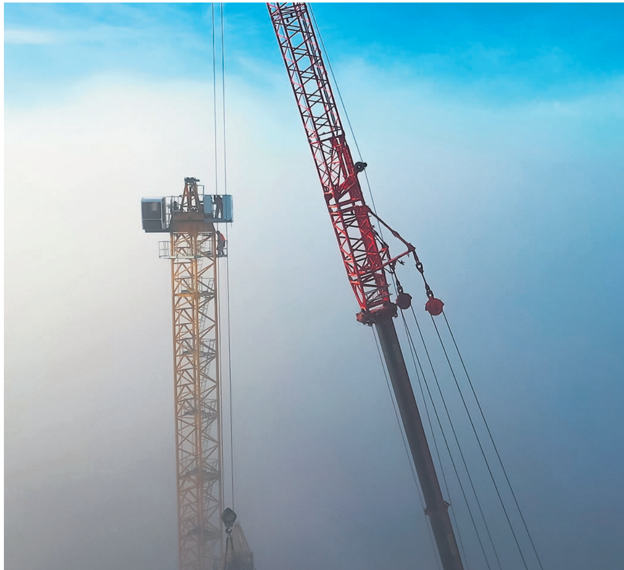
Beim Aufbau am 8. Januar knackte der grössere der beiden Kräne die Nebelobergrenze.
