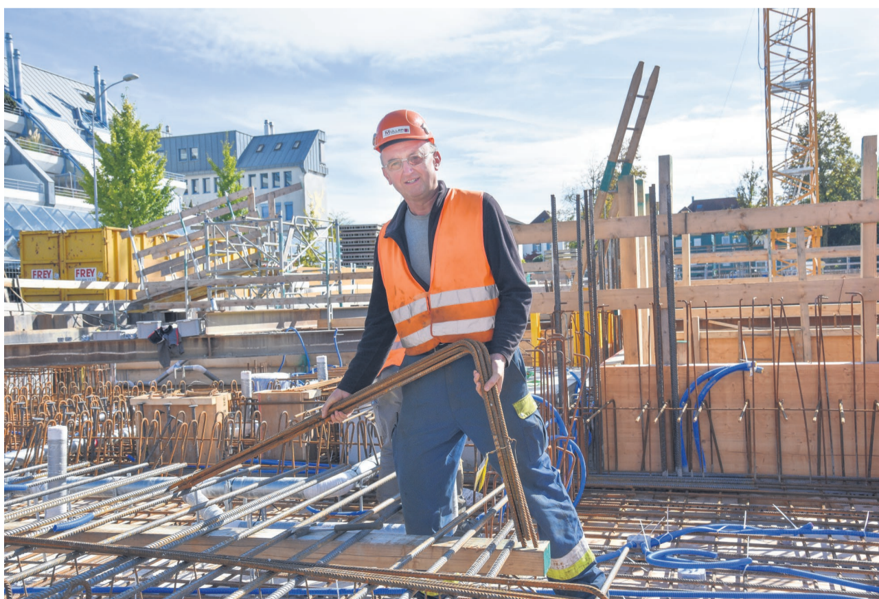
Miroslav Pendic legt auf der «Dreiklang»-Baustelle schwere Eisen und muss Pläne lesen können.
