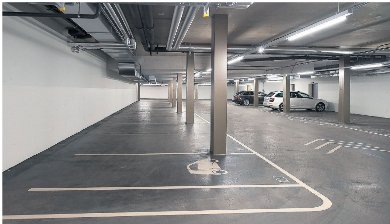
Ein Bild der Parkgarage des «Dreiklangs».
